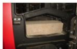
Obrázek číslo 7. Umístění keramického katalyzátoru na poličkách výměníku kotle KLIMOSZ COMBI / MULTICOMBI
