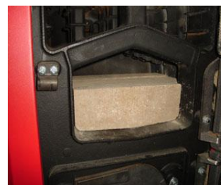
Rys.28. Umiejscowienie płyt ceramicznych w kotle KLIMOSZ UNIPELET.
